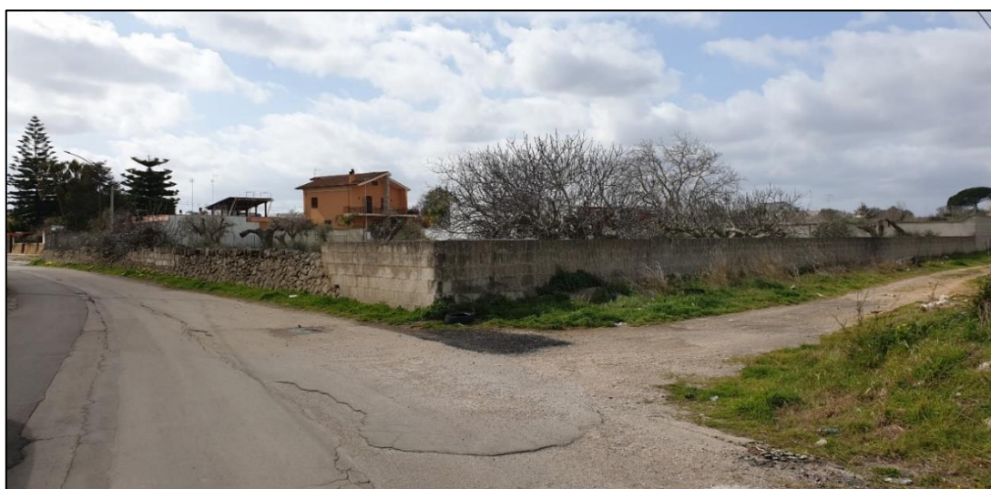
Figura 3-4. Foto 3 - Via G.Elia (direzione sud-ovest)
