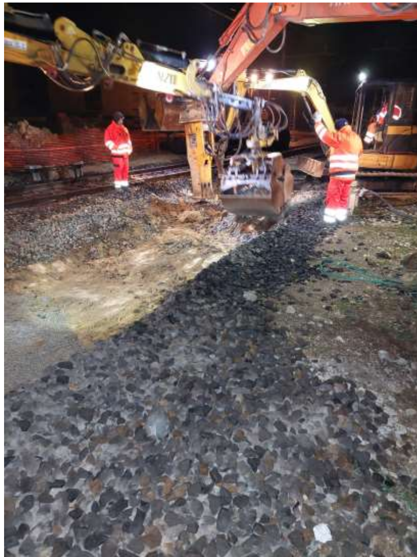
Figura 1 Attività lavorativa eseguita durante l'interruzione notturna alla circolazione dei treni
